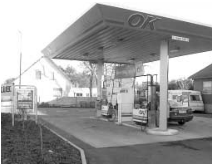
Det nye OK-anlæg
