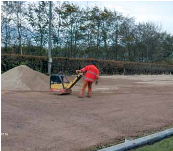
Der bliver kørt nogle omgange med vibratoren
