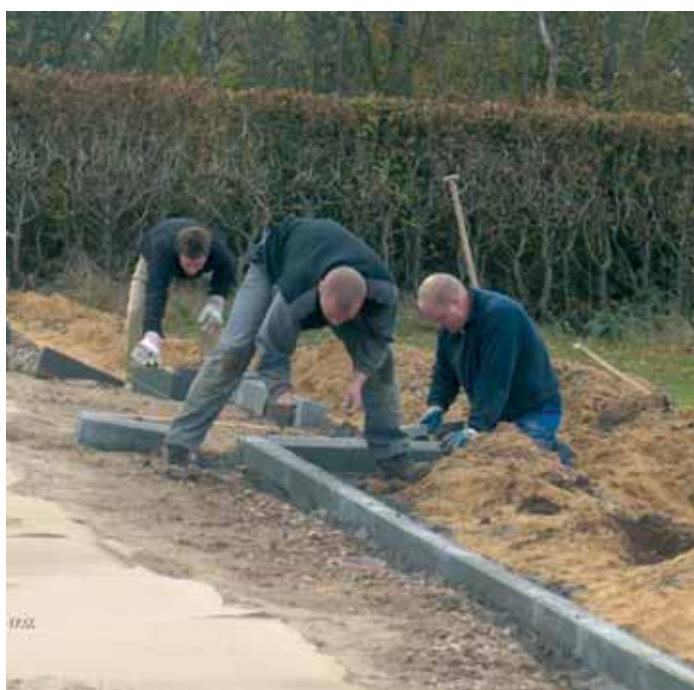
Der bliver støbt og lagt kantfliser ned
