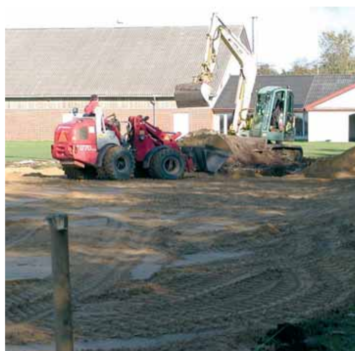
Sandet bliver jævnet og der bliver planeret
