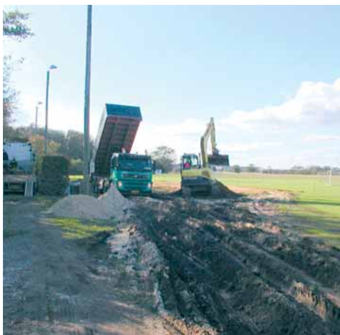
Der bliver kørt masser af jord fra og ligeså meget sand til.
