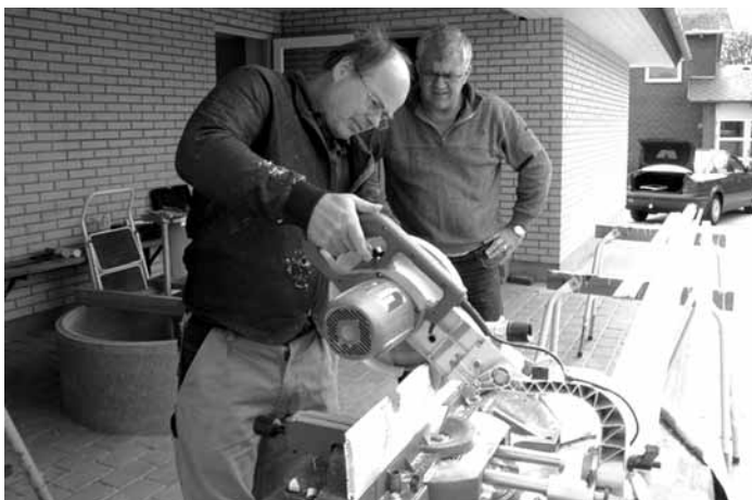
Formand Henning Frederiksen og Laurids Kristoffersen er ved at lægge sidste hånd på loftsbrædderne
